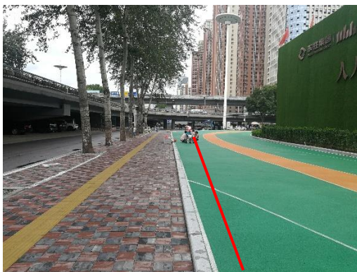
电缆隧道施工场地恢复后
