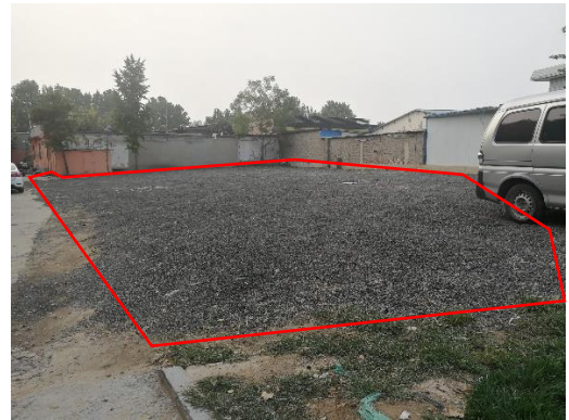
顶管作业施工场地恢复后
