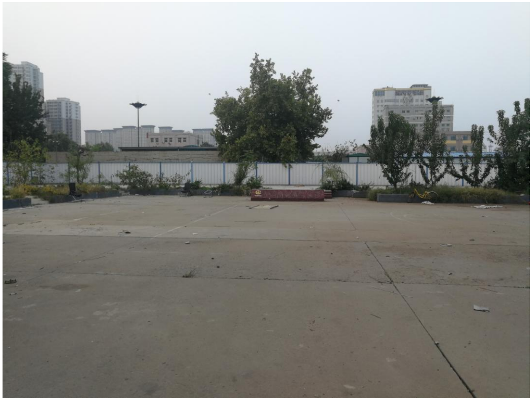
图 8-2 14 标 3 工部驻地拆除后照片
